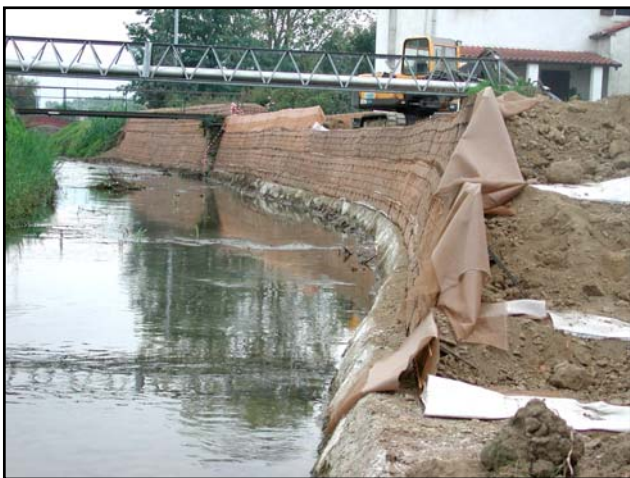
Figura 20: Esempi di pendii ripidi e muri in terra rinforzata con Geogriglie ARTER® e Geocompositi MACRIT®.
