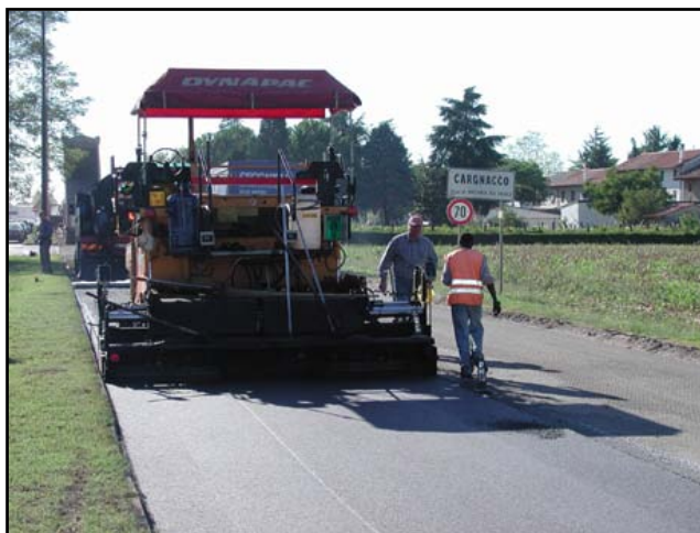
La fig. 31 mostra alcune fasi della posa in opera di ARTER® GTS A.
