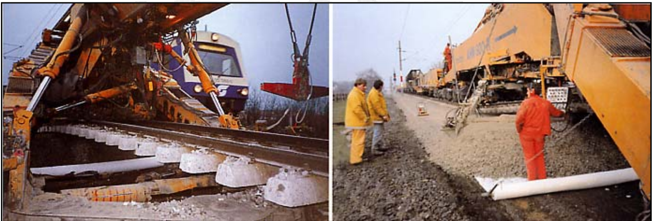
Figura 25: ARTER® e MACRIT® utilizzati per il rinforzo del ballast di una massicciata ferroviaria
