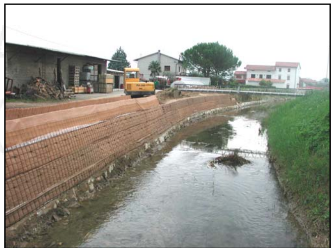
Figura 20: Esempi di pendii ripidi e muri in terra rinforzata con Geogriglie ARTER® e Geocompositi MACRIT®.
