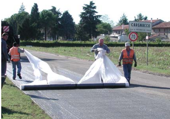
Fig. 6 - Tirando il foglio di Polietilene la Geogriglia si srotola uniformemente sullo strato di supporto, senza creare pieghe e ondulazioni
