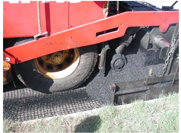
Fig. 11 - stesa dell'asfalto in spessore di 60 mm sciolto a mezzo di finitrice
