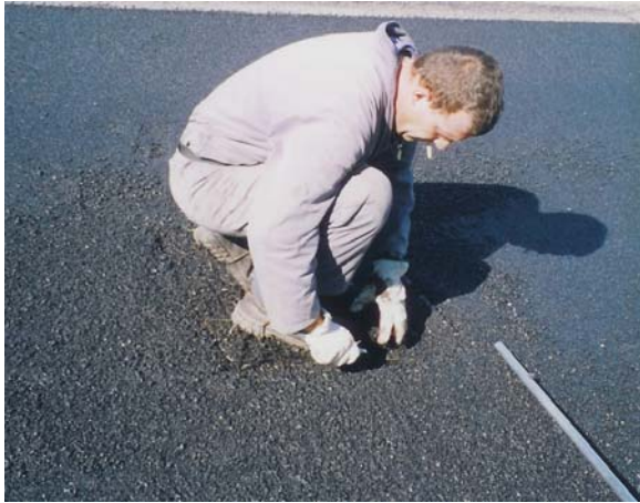
Fig. 10 – Taglio manuale della Geogriglia attorno ai pozzetti e ai tombini
