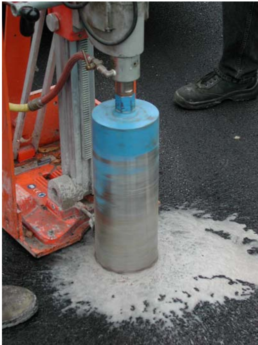
Fig. 12 - Carotaggio eseguito con Milwaukee Cat. No. 4004/4, con carotatrice da 160 mm
